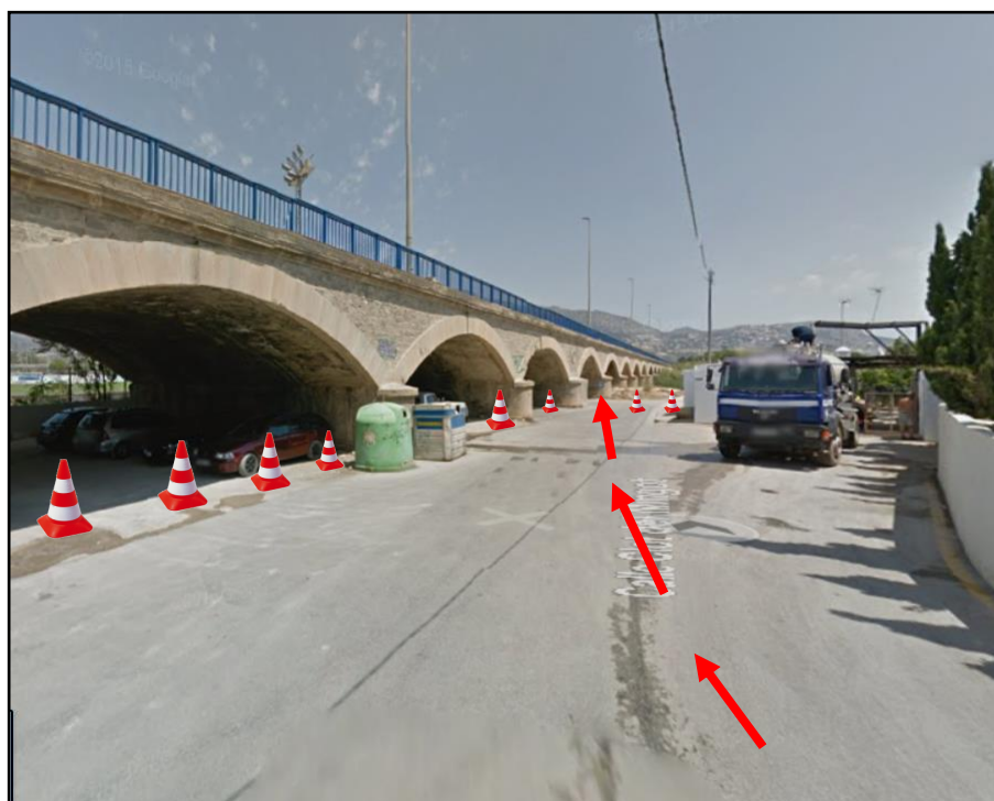
PASO POR EL CUARTO ARCO, SENTIDO TRÁFICO
