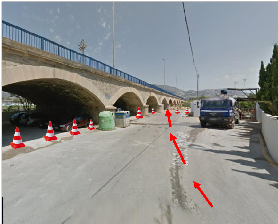
PASO POR EL CUARTO ARCO, SENTIDO TRÁFICO
